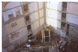
Die vorelementierten Hochwärmegedämmten Fassaden wurden vor den Rohbau gehängt.
