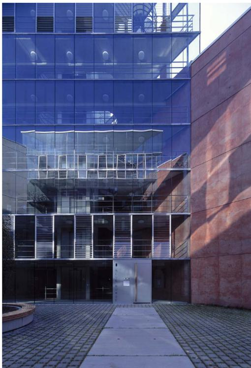
Das „low-tech“ Treppenhaus ohne Ausbaumaterialien und mit der Verwendung einfachster Industrieprodukte wird zum maßgebenden Gestaltungsmerkmale.
