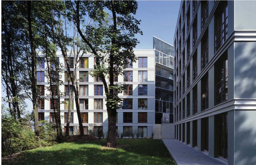
Die im Passivhausstandard gedämmten Bauteile staffeln sich in kompakter Bauweise um den zentralen Platz und die beiden ungedämmten Treppenhäustürme.
